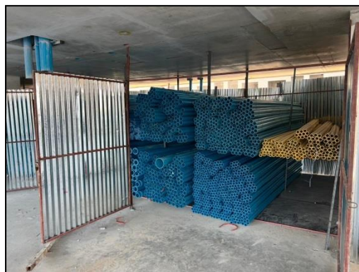
รูปที่ 6 การจัดเก็บวัสดุ อุปกรณ์ เครื่องมือที่ใช้ในงานก่อสร้างให้วางอย่างเป็นระเบียบ
