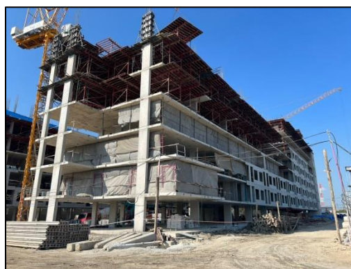
รูปที่ 5 Mesh Sheet รอบตัวอาคาร
