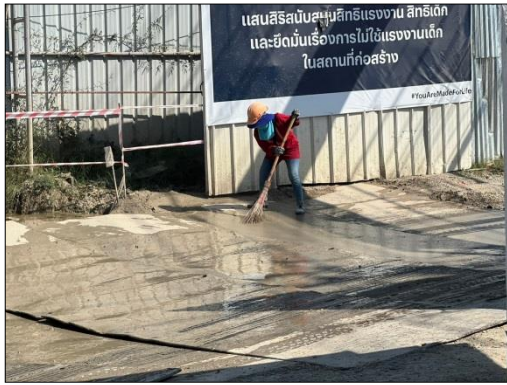
รูปที่ 17 คนงานควบคุมและลดปริมาณน้ำไหลและน้ำโคลนบนพื้นที่ก่อสร้าง
