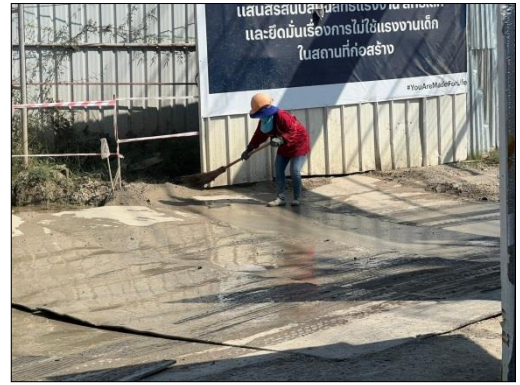
รูปที่ 17 คนงานควบคุมและลดปริมาณน้ำไหลและน้ำโคลนบนพื้นที่ก่อสร้าง
