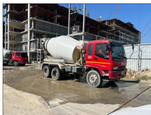
รูปที่ 15 พื้นที่สำหรับล้างล้อรถก่อนออกนอกโครงการ
